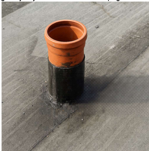
Slika 3 Podizanje bitumena na prolazu cijevi
