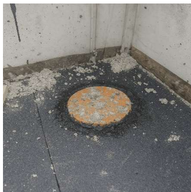
Slika 2 Brtvljenje hidroizolacijskom masom za cijevni spoj u ravnini s podnom pločom
